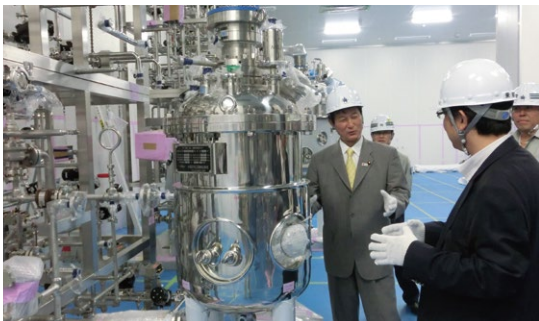
アストラゼネカ社が供給するワクチンは、北本市の北里大学メディカルセンターに隣接する第一三共のワクチン工場で充填(瓶詰め)され、全国に出荷されています(写真 建設中の同工場を視察しました。)
